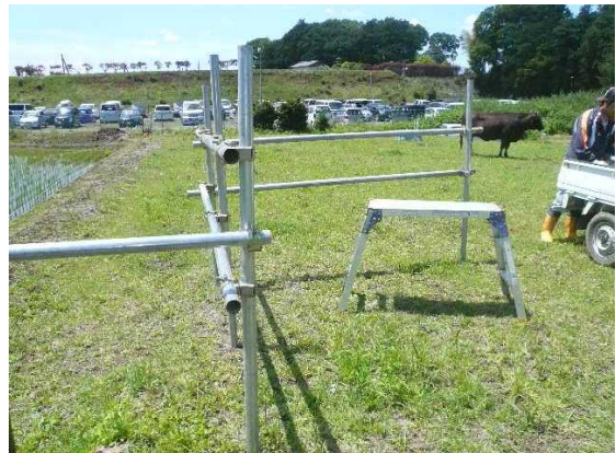
図7 単管パイプで組み立てた障壁兼けい留施設
